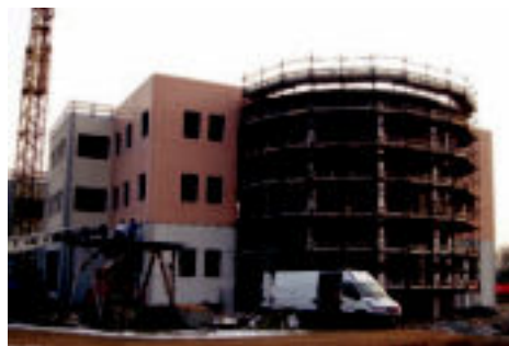
2003 - Inizio costruzione della sede di Caselle.
