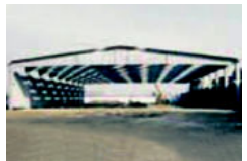
1984 - Ampliamento del magazzino di Via Frejus ad Orbassano.
